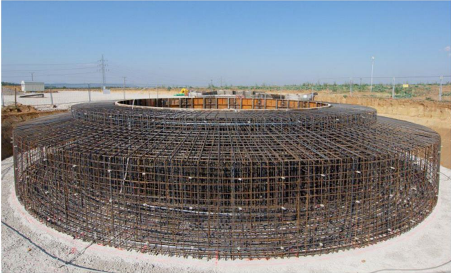
Fundamentarmierung für Windindustrieanlage Enercon E82 in Ingersheim Nabhöhe nur 78 – 138 Meter
